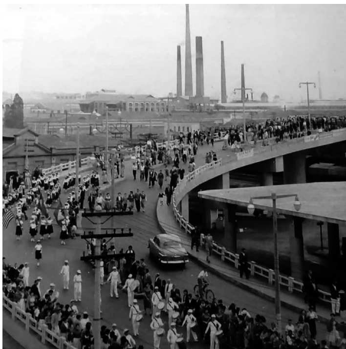
Figura 3: Viaduto dos Autonomistas.
