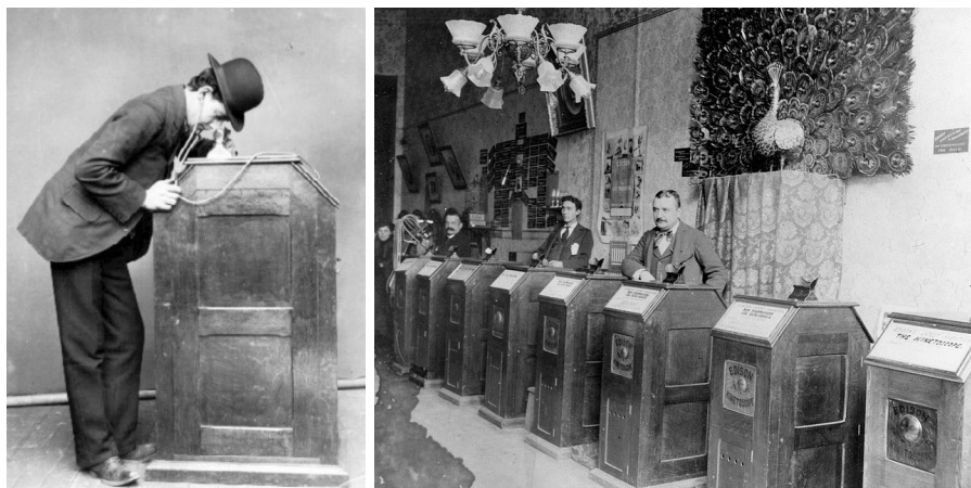
Figura 02: Quinetoscópio de Thomas Edison. Na foto à esquerda, podemos ver os conectores auriculares. Fonte: Wikimedia 5
