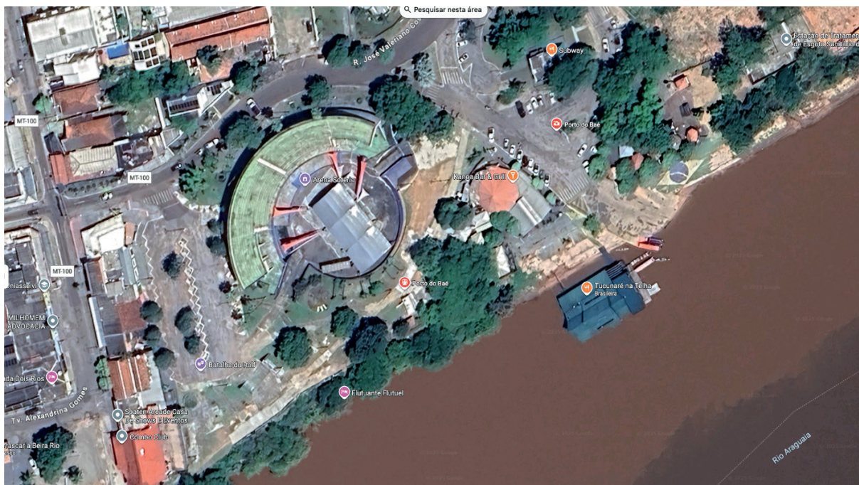
Figura 5. Vista Aérea do Porto do Baé.
